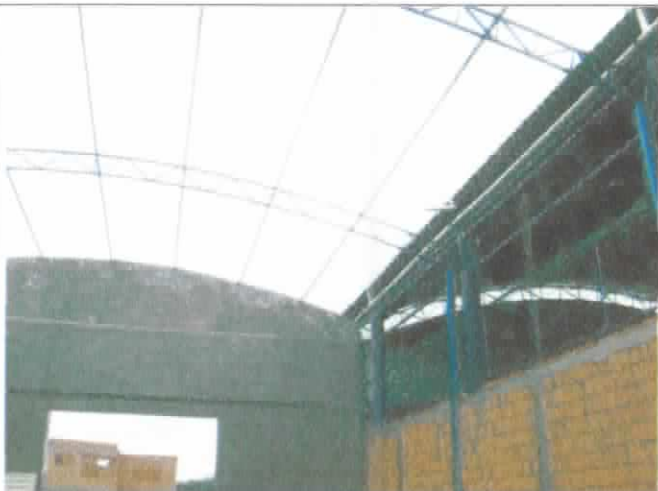
FOTO 04: DETALHE DA ESTRUTURA METÁLICA SEM ACABAMENTO
