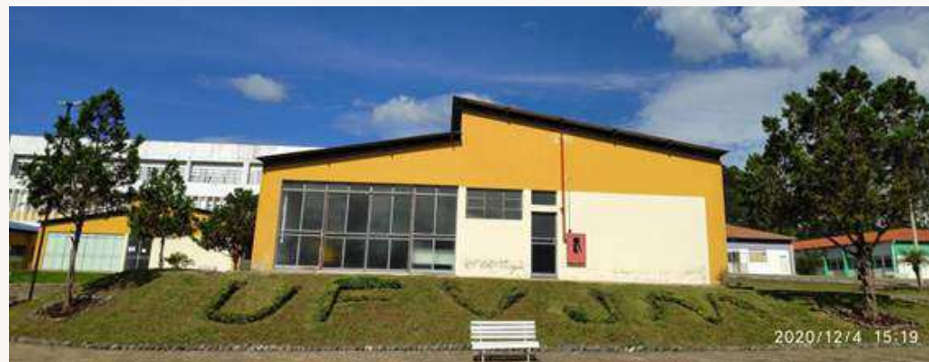
Reforma do jardim em frente à antiga Biblioteca (Foto: Celmo Aparecido Ferreira)
