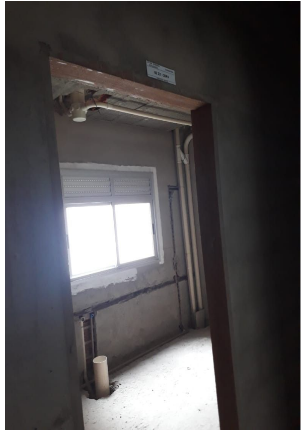
Figura 2 - Detalhe do andamento da obra com foco na situação interna de um apartamento, com instalação hidráulica de banheiro.
