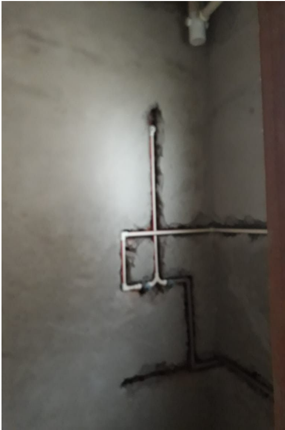
Figura 2 - Detalhe do andamento da obra com foco na situação interna de um apartamento, com instalação hidráulica de banheiro.
