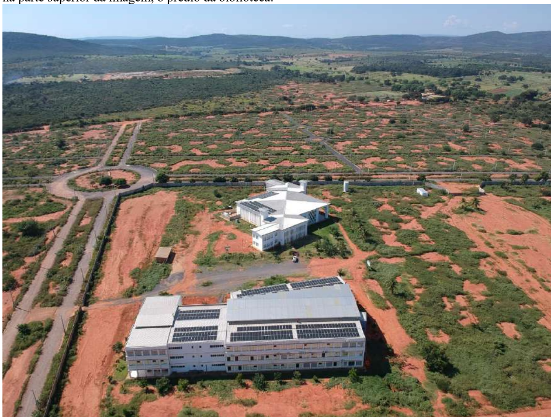
Figura 1: Vista aérea do Campus Janaúba. Na parte inferior da imagem temos o prédio de salas de aula e, na parte superior da imagem, o prédio da biblioteca.
