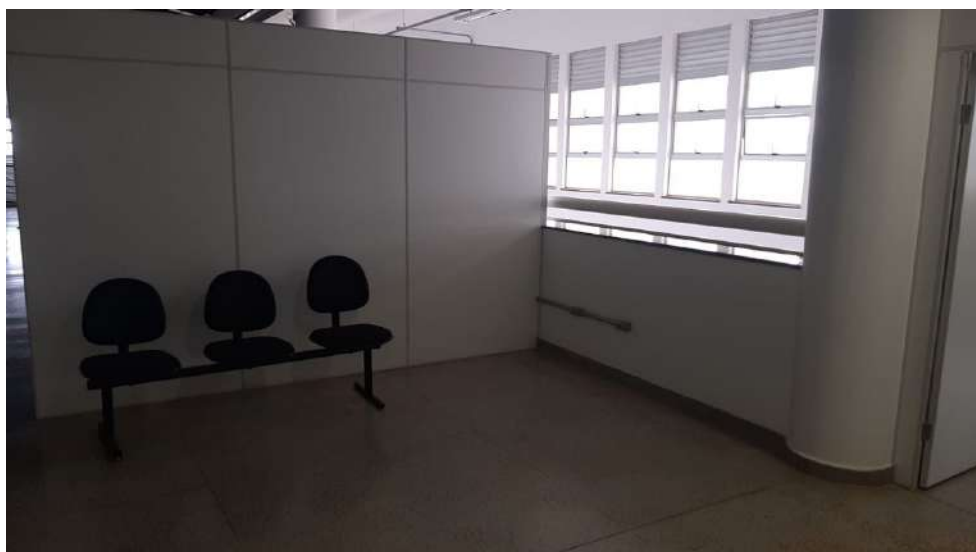
Figura 69. Espaço ao lado da sala de convivência.
