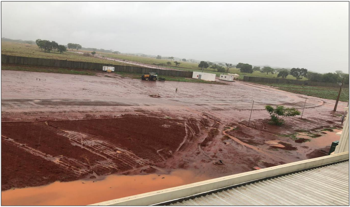
Figura 7 - Campus de Unai no qual se pode notar a ausência de pavimentação e urbanização. Em dias de chuva o acesso ao Campus fica comprometido.
