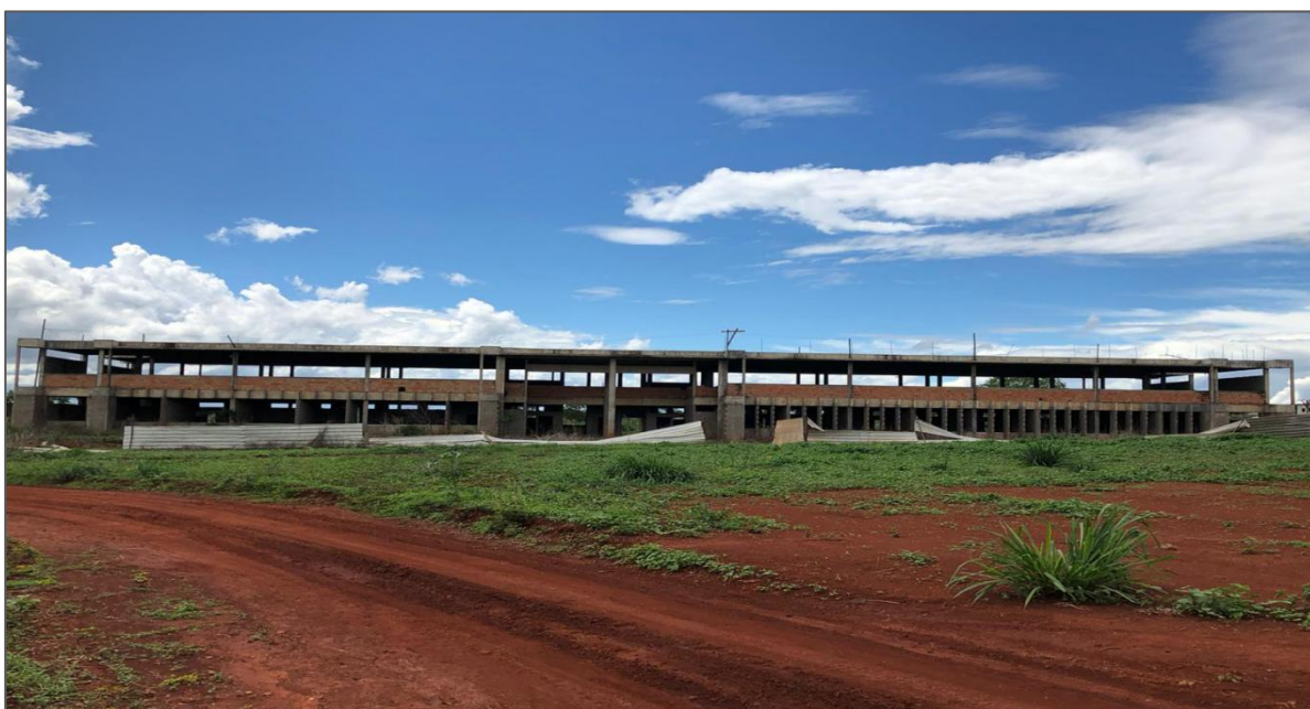
Figura 5 - Obras paralisadas do Prédio Administrativo do Campus de Unaí.
