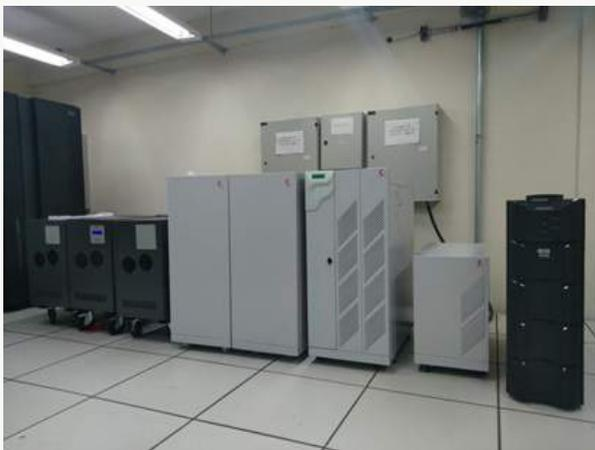
Nobreaks do Data Center em pleno funcionamento (Foto: DTI)
