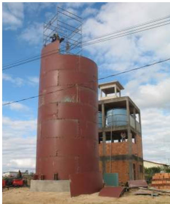
Construção do novo reservatório d'água do Campus JK
