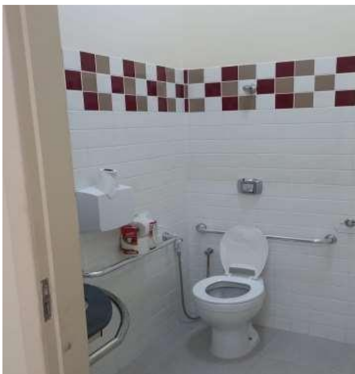
Imagem 35: Banheiro Masculino adaptado
