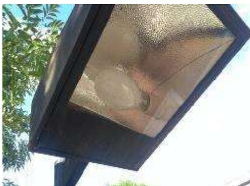
Figura 7.6 - Lâmpada Vapor de Sódio Existente na Instalação
