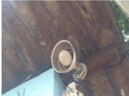
Figura 7.8 - Lâmpada Vapor Metálico Existente na Instalação
