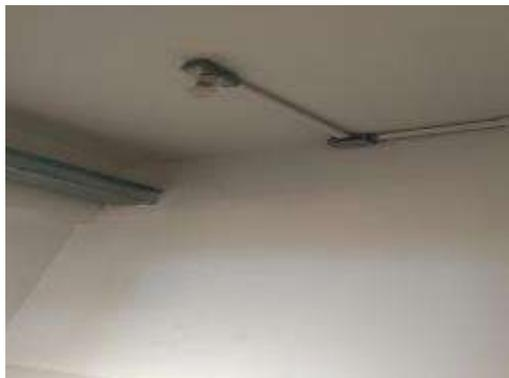
Figura 7.5 - Lâmpada Incandescente Existente na Instalação
