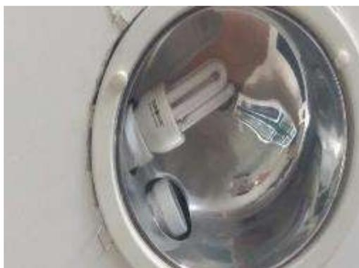
Figura 7.7 - Lâmpada Fluorescente Compacta Existente na Instalação
