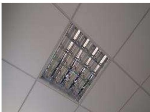
Figura 7.3 - Lâmpada Fluorescente Tubular Existente na Instalação
