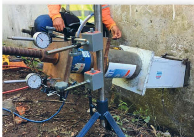
Figure 6 : L' quipement des essais de traction (Rincent Laboratoires)
