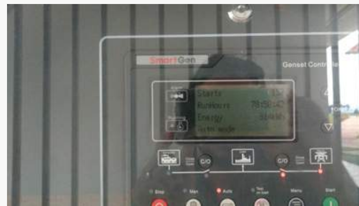
Horímetro do gerador com registro de aproximadamente 80 horas de operação (Foto: DTI)
