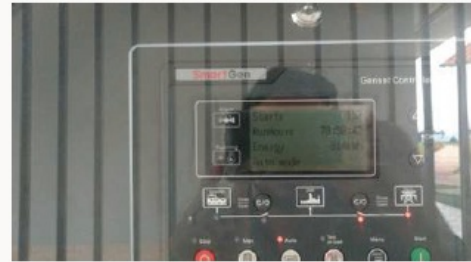
Horímetro do gerador com registro de aproximadamente 80 horas de operação (Foto: DTI)
