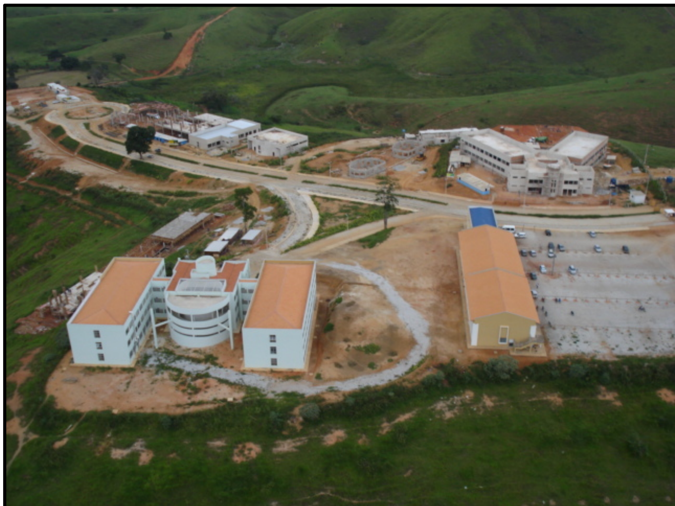
Figura 01: Campus do Mucuri em franca construção.
