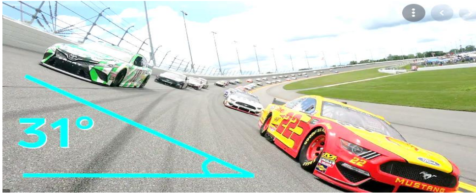
Fig. 1 – Exemplo de pista compensada. O triângulo da foto indica o ângulo de inclinação da pista.
